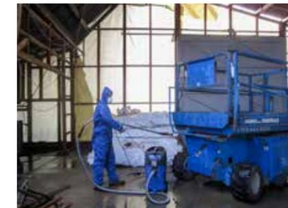
Schulallee 31: Aufgrund der stark asbesthaltigen Bauteile musste mit einem Schwarzbereich gearbeitet werden
